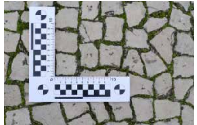
Fig. 32 - Medição de calçada na Praça do Império, anos de 1940. Pedras de tamanho médio de 4X4cm para calçada de passeio. (Foto: EM)
