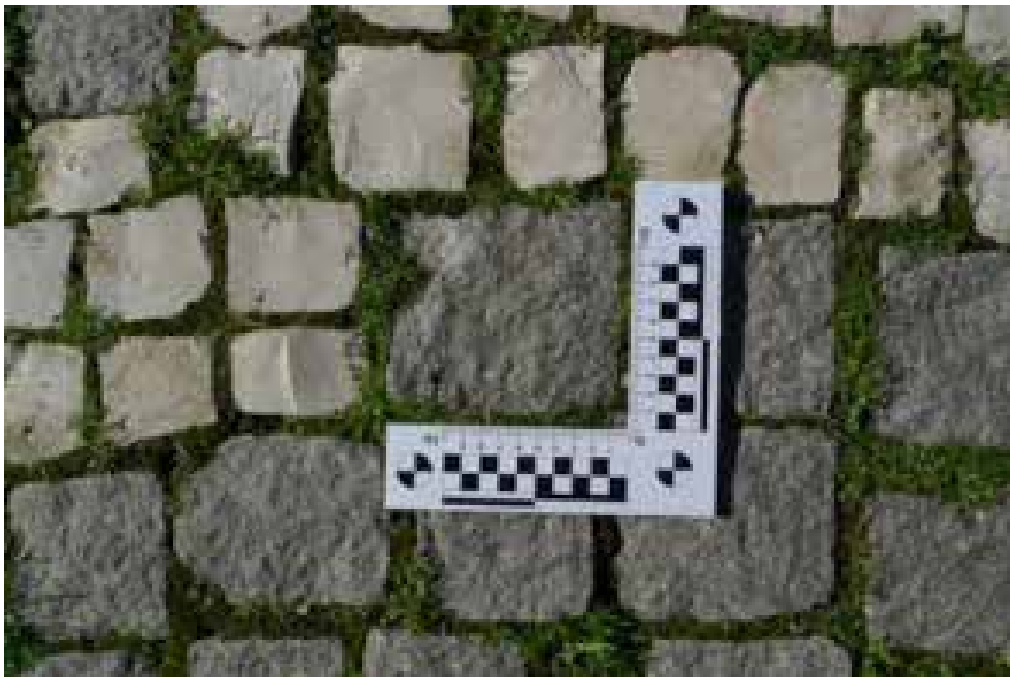
Fig. 20 - Medição da pedra de granito para comparação de materiais. (Foto: EM)
