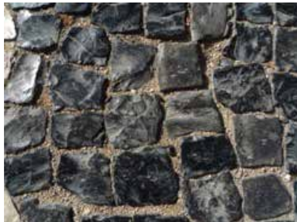
Fig. 28 - Pormenores de pedras de calcário branco no espaço da Expo'98 com uma má colocação e sem o cuidado no encaixe, bem como o uso de pedras de má qualidade e por vezes com tamanhos irregulares. (Fotos: EM)
