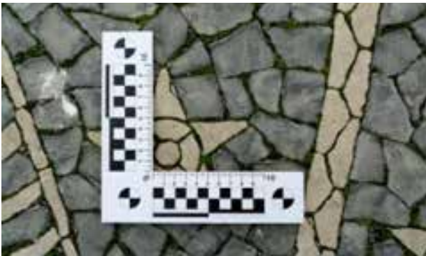
Fig. 33 - Medição de calçada na Praça do Império, anos de 1940. Pedras de tamanho médio de 4X4cm ou mais reduzidas para calçada artística. (Foto: EM)
