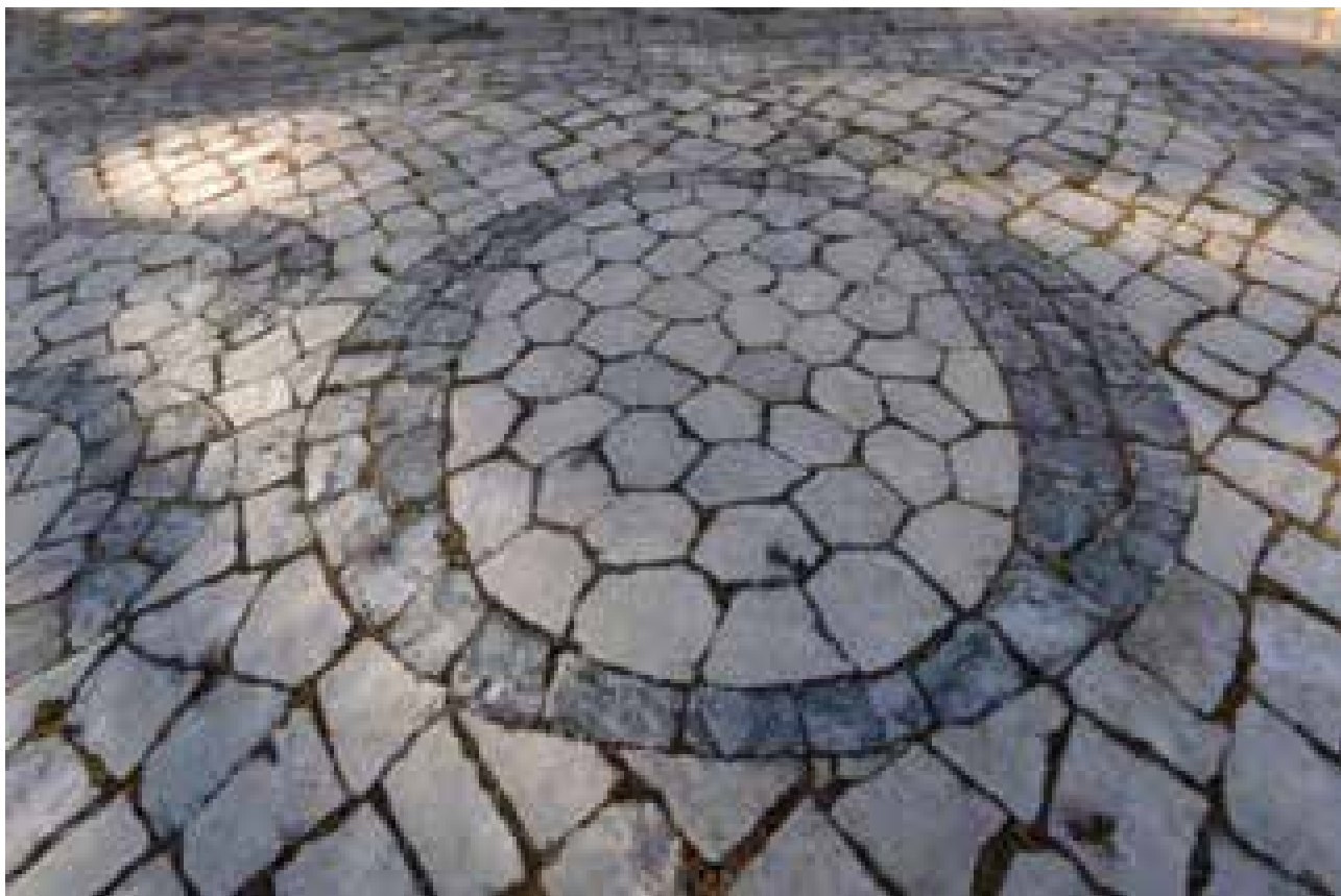
Fig. 37 - Pormenor de encaixe no interior da letra, feito no processo designado de “malhete” e que se afasta do restante trabalho feito no exterior destas letras. Aplicado no Largo das Bicas, projeto “Kanimambo” de Ângela Ferreira. (Foto: EM)
