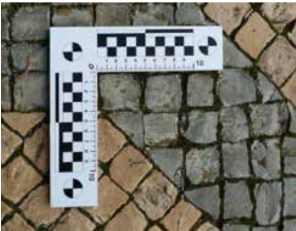
Fig. 35 - Medição de calçada no Jardim do Palácio do Marquês de Pombal, Oeiras, anos de 1960. Pedras de tamanho médio de 4X4cm. (Foto: EM)
