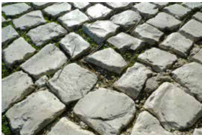
Fig. 28 - Pormenores de pedras de calcário branco no espaço da Expo'98 com uma má colocação e sem o cuidado no encaixe, bem como o uso de pedras de má qualidade e por vezes com tamanhos irregulares. (Fotos: EM)
